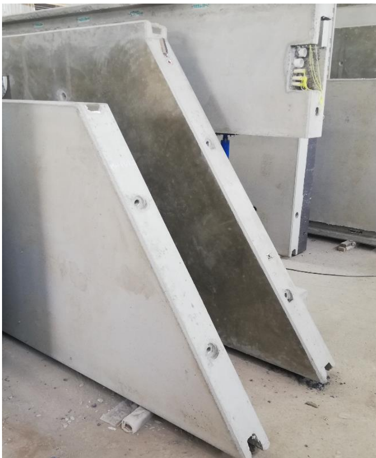
Zdjęcie 2. Różnice kolorystyczne między powierzchnią szalunkową, a zacieraną mechanicznie
