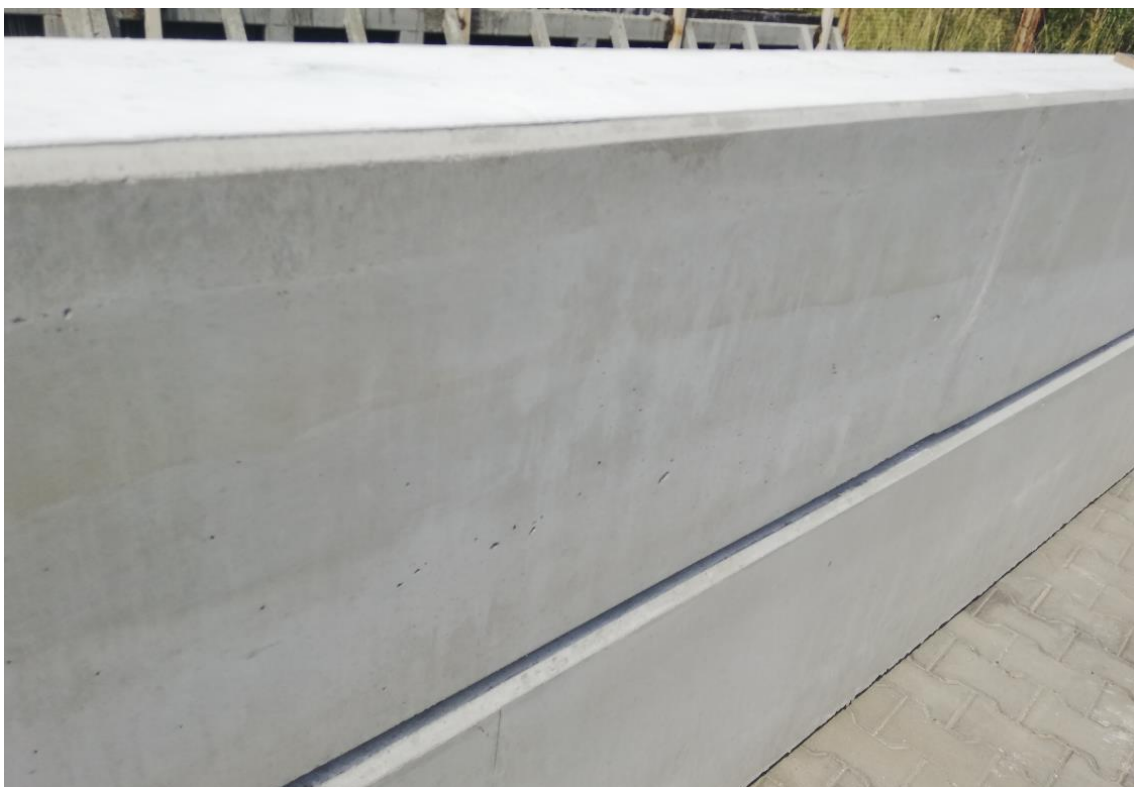
Zdjęcie 7. Różnice kolorystyczne na powierzchni prefabrykatów
