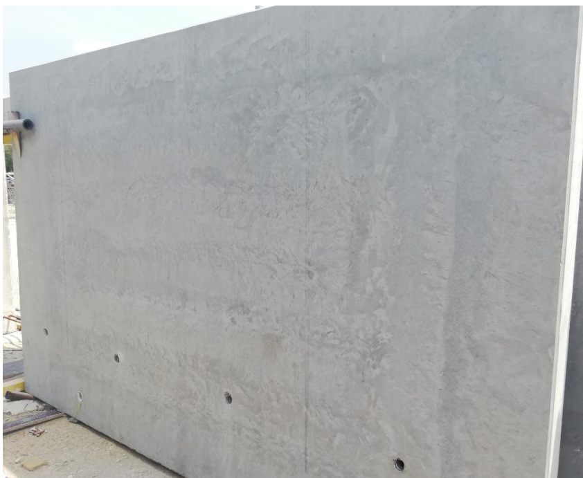
Zdjęcie 7. Różnice kolorystyczne na powierzchni prefabrykatów
